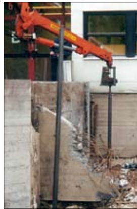
Ort-ruuvipaalutus sanerauskohteessa. Puomin ulottuvuus 17 m.
