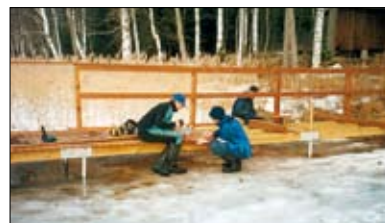
Laituritolpat asennetaan helpoiten jään läpi
