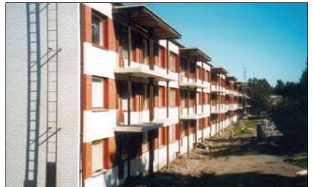
Kerrostalon parvekesaneeraus, jossa on käytetty Ort-ruuvipaalutusta
