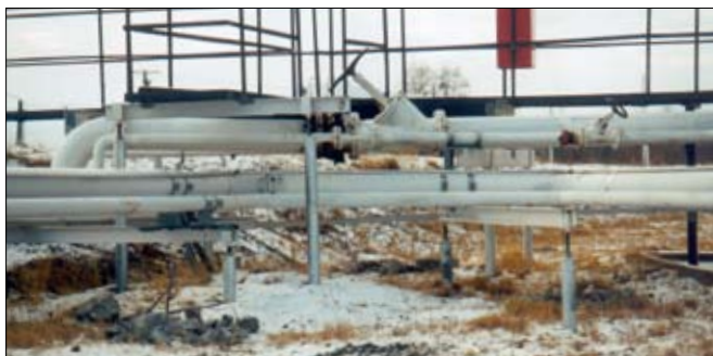
Öljysataman putkilinjojen kannatukset asennettu Ort-ruuvipaalujen päälle.
