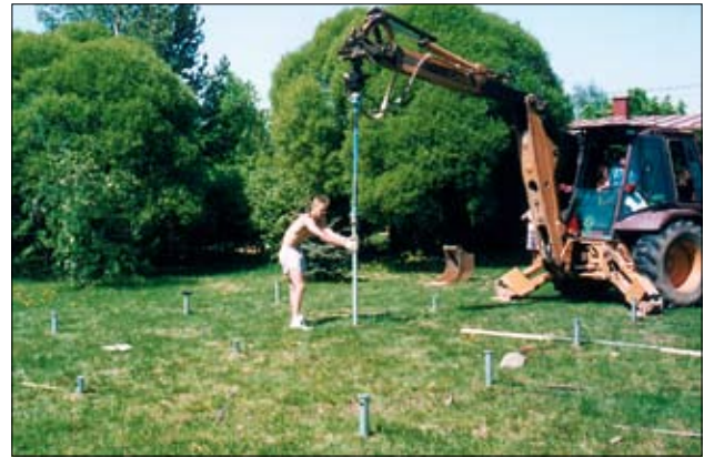
Hirsimökin ruuviperustuksen asennus. Unohda kaivuumaansiirtotyöt, laudoitukset, raudoitukset ja valutyöt.
