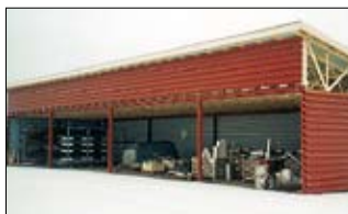
Varastohalli, ruuvipaalut kierretty asfaltin läpi.
