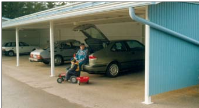
Kahdeksan auton autokatos, ruuviperustukset kierretty asfaltin läpi.
