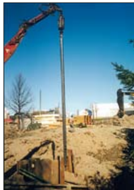
Ort-ruuvipaalutuksen kiertäminen koneellisesti
