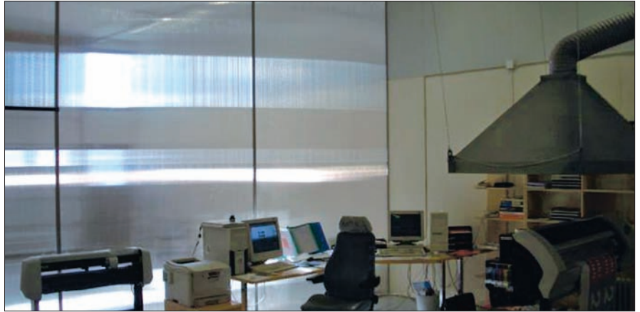
Kevyt ja valoisa väliseinä Lexan-kennolevystä.
