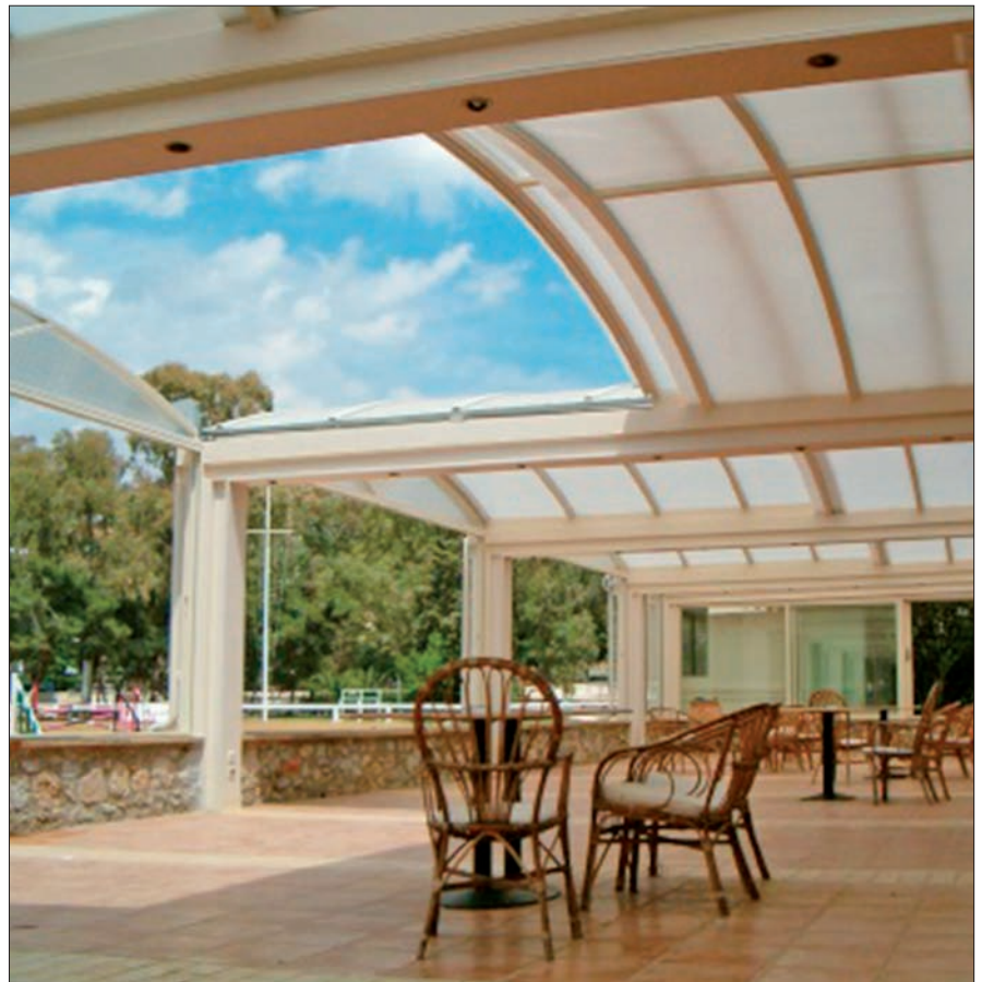
Opaali Lexan Thermoclear -levyjä terrassin katteissa
