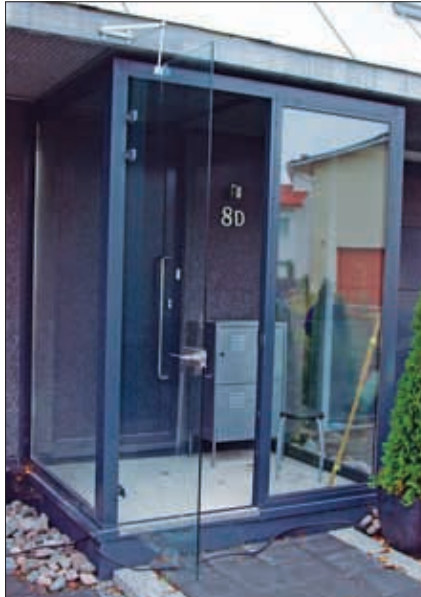
Tuulikaappi, joka on rakennettu Masi-lasitusjärjestelmällä
