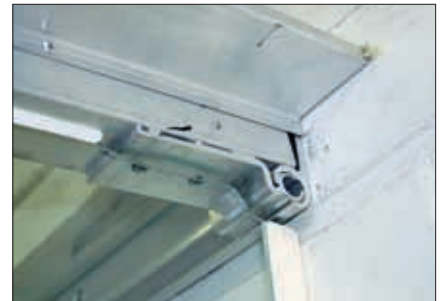
Kattokannakkeen kiinnitys seinään nivelkiskolla
