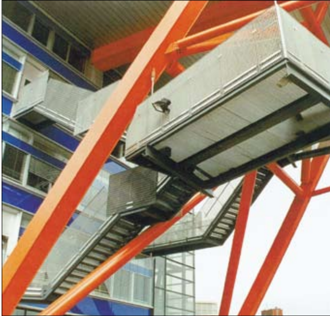
STR-teräsritiä portaikon kaiderakenteissa
