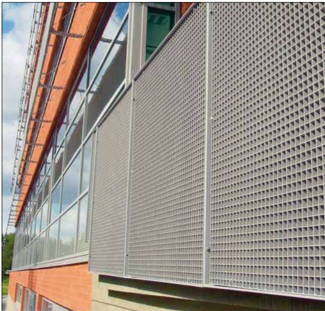
STR-täyspuristeritiä julkisivuna ja auringonsuojana
