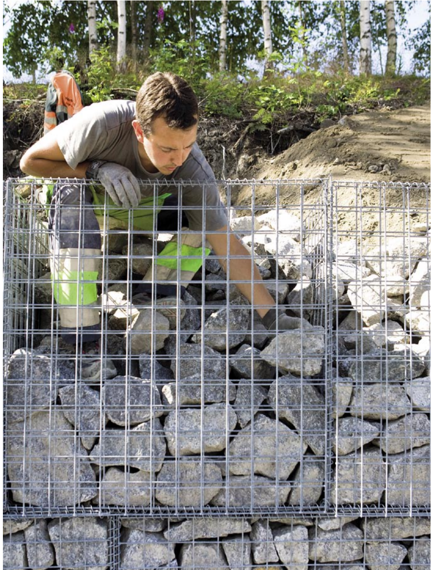
Tukimuurin asennustyö käynnissä Vt 8 varrella Vaasassa.
