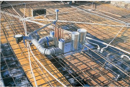
Kuva 9. Esivalmistettu viemärihajoitus nopeutta asennustyötä eikä hidasta muuta holvityötä.
