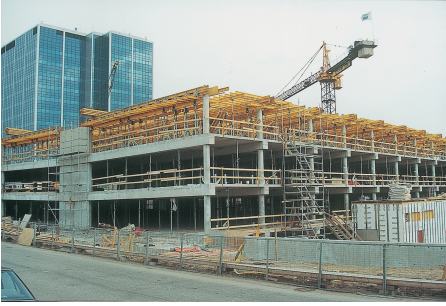
Kuva 2. Nykyaikaista holvimuottikalustoa työmaalla. Hyvä ennakkosuunnittelu mahdollistaa tehokkaan muottikierron.
