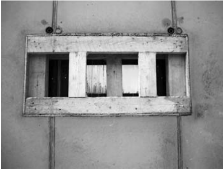
Kuva 5. Itsetiivistyvällä betonilla saadaan virheetön valujälki myös vaikeisiin valukohtiin.
