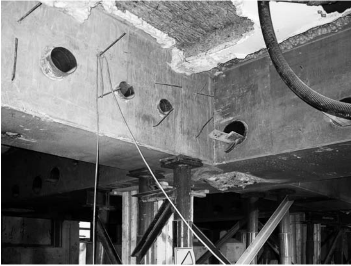
Kuva 9. Itsetiivistyvällä betonilla valettuja jännitettyjä vahvistuspalkkeja. Vanhan välipohjan alle tehdyt rakenteet betonoitiin muotin pohjasta painevaluna. Pisimmät palkit olivat noin 23 metriä pitkiä.
