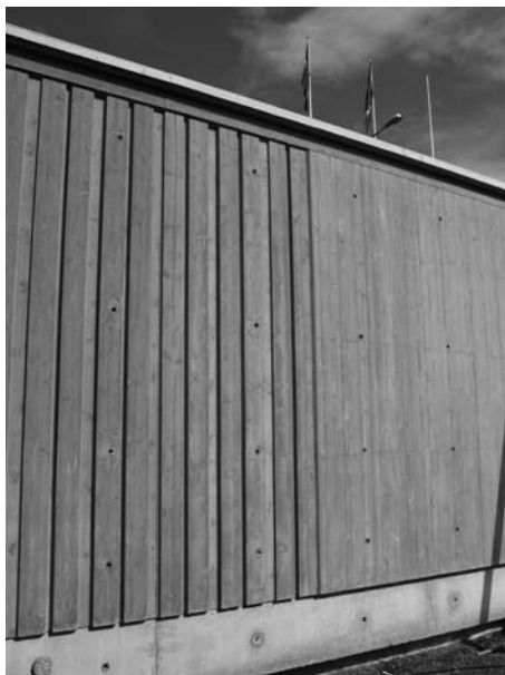
Kuva 8. Itsetiivistyvällä betonilla valettua tukimuuria. IT-betoni pumpattiin muottiin rakenteen alaosaan.
