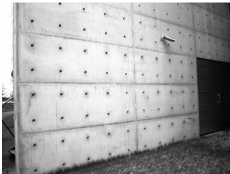
Kuva 2. Itsetiivistyvällä betonilla kertavaluna yhtäjaksoisesti betonoitu 7,5 m korkea ja 9 m leveä seinämäinen rakenne.
