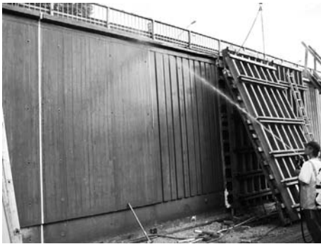
Kuva 6. Itsetiivistyvä betoni vaatii huolellista jälkihoitoa. Kuvassa tukimuurirakenteen jälkihoitoa kastelulla ja muovipeitolla.
