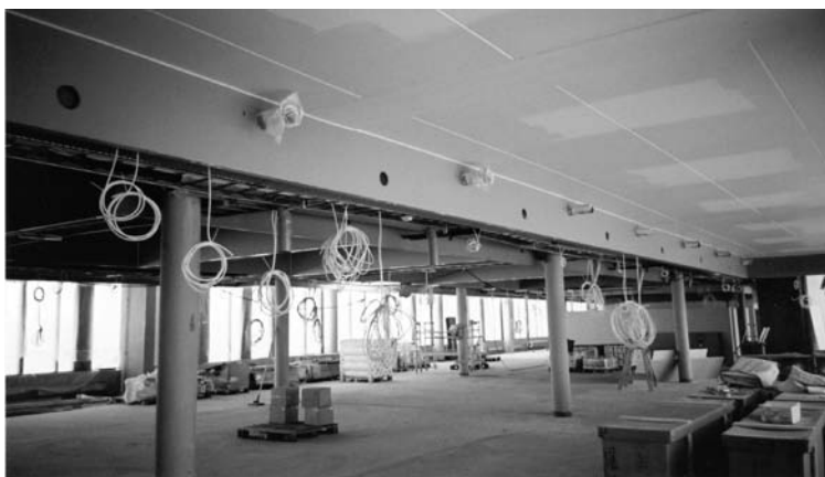
Kuva 1. Työmaan siisteydestä ja puhtaudesta tulee huolehtia jo koko rakennushankkeen ajan. Tämä helpottaa työn tekemistä ja edistää myös työturvallisuutta. Tässä esimerkki siististä työmaasta.
