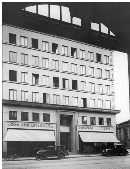
Kuva 14. Sigurd Frosterus, Ole Gripenberg: Helsingin Säästöpankin konttori, Helsinki 1932. Rakennus edustaa liikearkkitehtuurille tyypillistä pelkistettyä klassisimista.
