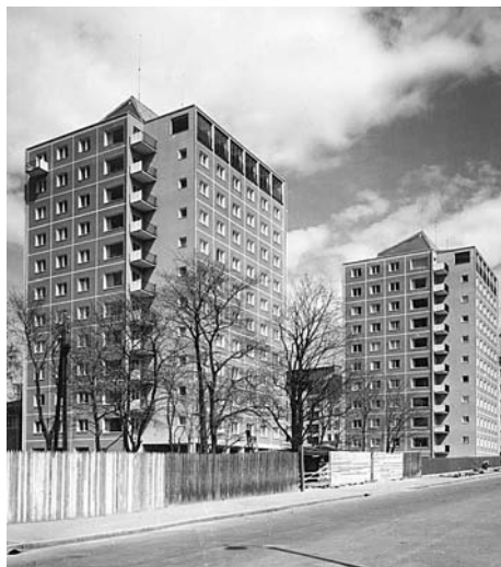
Kuva 38. Martta-Martikainen Ypyä ja Ragnar Ypyä: Kivelän sairaalan sairaanhoitajien asunnot, Helsinki 1954. Rakennuksissa on ruuturapaus, joka jäljittelee betonielementtejä.
