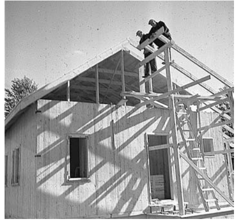
Kuva 22. Alvar Aalto: A. Ahlström Oy:n Varkauden talotehtaan esivalmistaman tyypitalon pystytys 1940.
