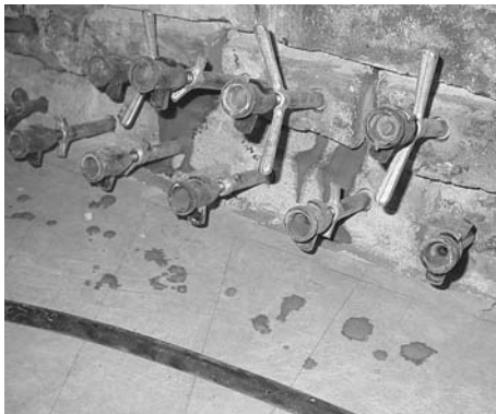
Kuva 7. Kapillaarikatkon paineellinen injektointi seinärakenteen alaosaan porattujen injektointireikien kautta.
