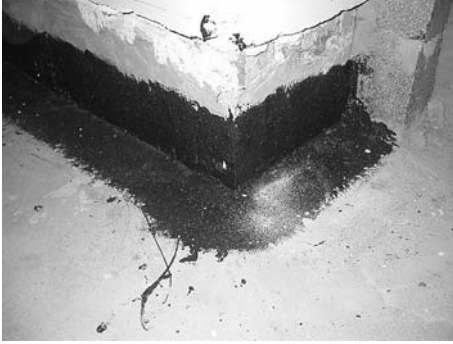
Kuva 4. Lattian ja seinän rajapinnassa olevan raon tiivistäminen massamaisella vedeneristeellä.
