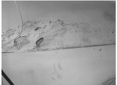
Kuva 3. Kosteuden mukana kulkeutuneet suolat ovat kiteytyneet seinän alaosaan asennetun levytyksen yläpuolelle.
