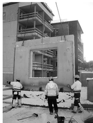
Kuva 1. Seinäelementin asennus.
