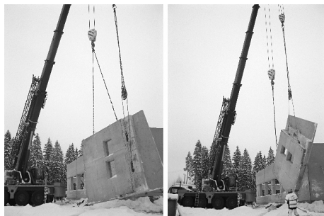
Kuva 5. Elementin kääntö kääntöpyörän avulla yhdellä ajoneuvonosturilla.
