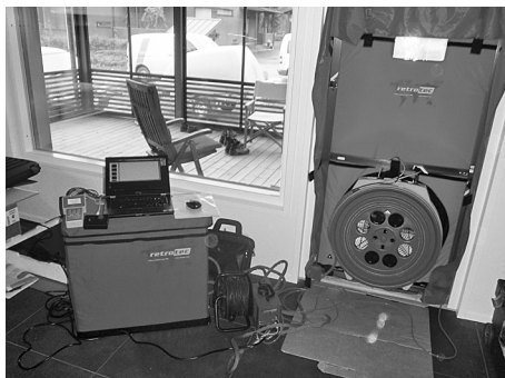
Kuva 1. Rakennuksen tiiviysmittauslaite käyttövalmiina.
