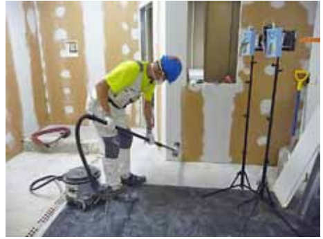
Kuva 7. Tasoitteen hiontaa: hengittyvä pöly 20 mg/m 3 (ilman kohdepoistoa 120 mg/m 3 ).
