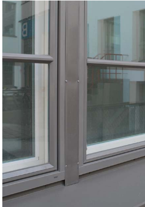
Kuva 4. Puualumiini-ikkuna. Profiilit ovat värianodisoituja.
