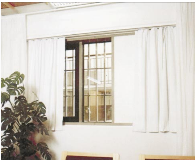
Moottorikäyttöiset sivulle vedettävät FP-pimennysverhot, Cultor Oy:n pääkonttori, Helsinki
